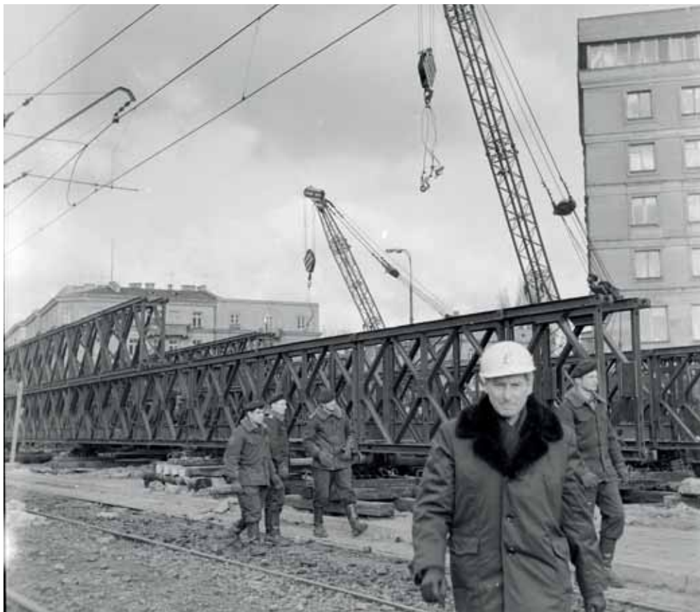
Budowa wiaduktu w Al. Niepodległości w 1972 r. Construction of the flyover at Niepodległości Avenue in 1972
